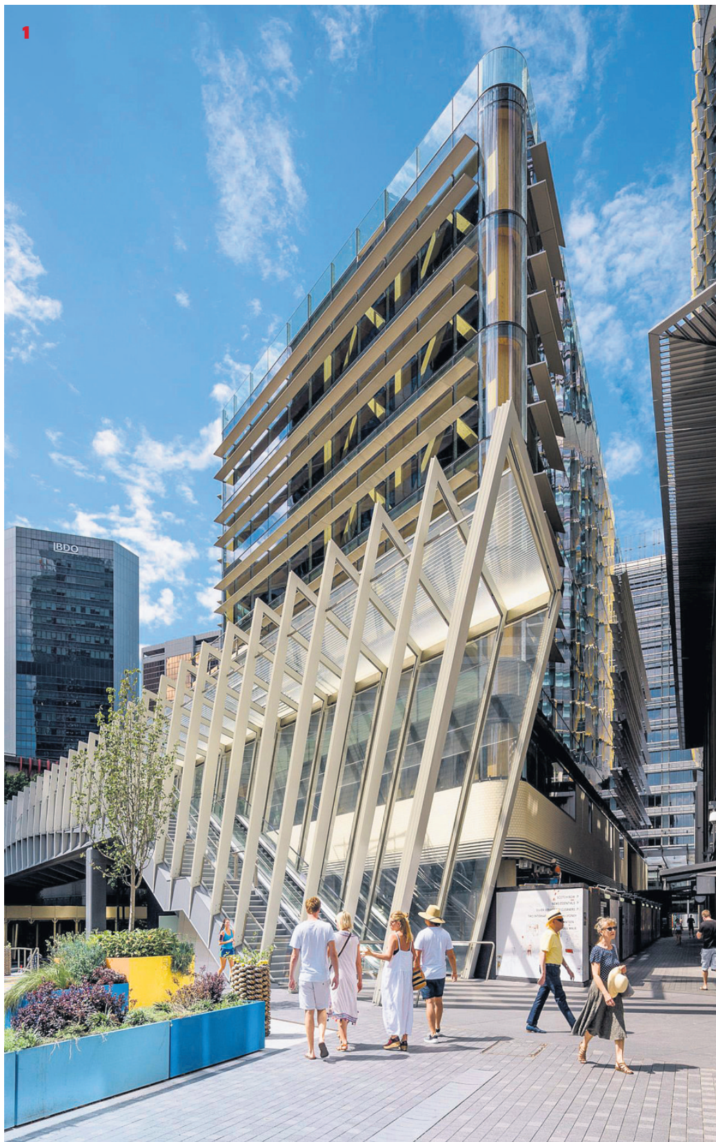
1 - International House, Sydney (Australie). Architectes: TZANNES. Achevé en 2016. L'armature du bâtiment commercial de sept étages a été construite en bois. Les architectes ont conçu une colonnade évoquant une forêt qui donne un caractère singulier à l'édifice. BEN GUTHRIE, THE GUTHRIE PROJECT
